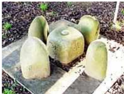
Рис. 6. Варіант закріплення геодезичного пункту
